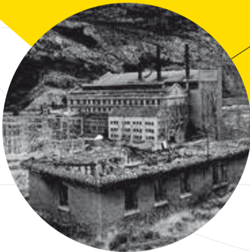
CENTRAL TÉRMICA DE ALIAGA
